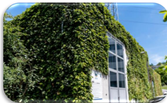
Holzschnitzel-Heizzentrale in Baar-Inwil
