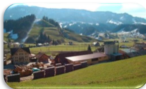
Betriebsgebäude der Josef Bucher AG
