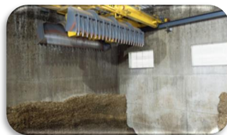
Holzschrotbunker der Heizzentrale Hofen
